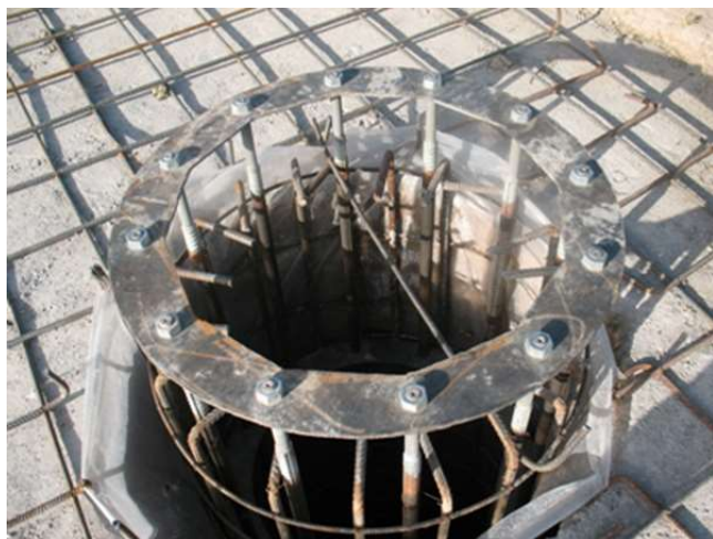
فونداسیون شمعی جهت دکل مونوپل
