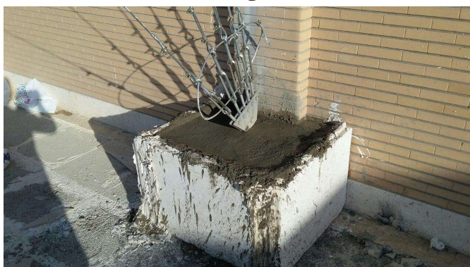
فونداسیون پایه مهار جهت دکل مهاری
